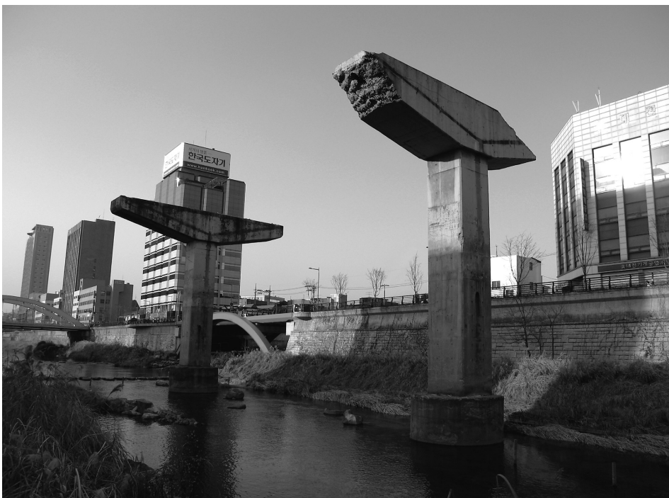
図12 復原された清溪川の最下流地点 過去の高架道路の痕跡
