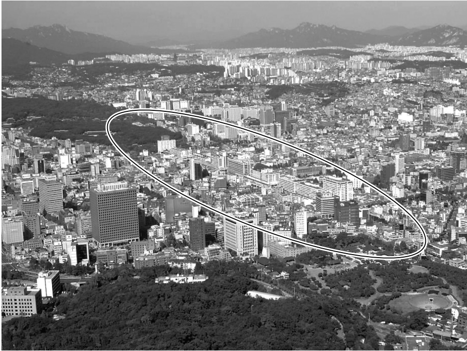
図13 宗廟から南山までの緑地帯の予定地 楯円内にある住・商複合建物を撤去し、緑地帯が新しく建設される予定である。
