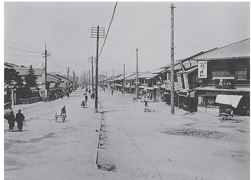
図2 「拡築」工事中の《祇園町》
